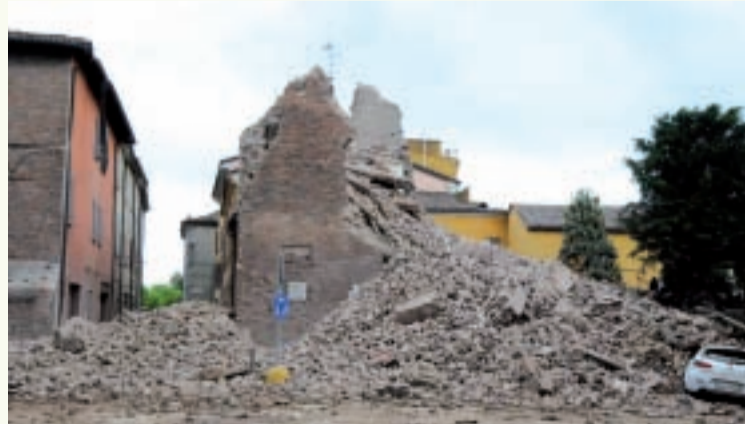
Il centro urbano di Cavezzo sotto le macerie
