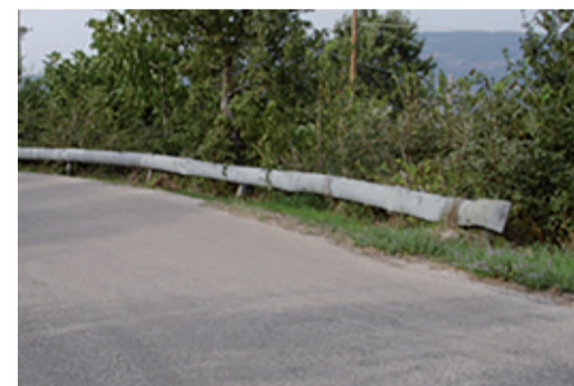
Nelle foto sopra e sotto alcuni esempi di come si presentano le nostre strade provinciali: frane e sconnessioni (1), guard rail deformati (2), muretti franati (3), segnaletica fatiscente (4).
